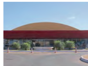
Concluídas Obras Bloco I
